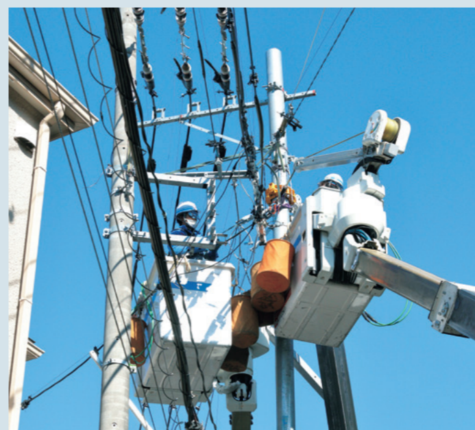
伸縮柱の仮アームへ旧柱の架空線を仮移設
