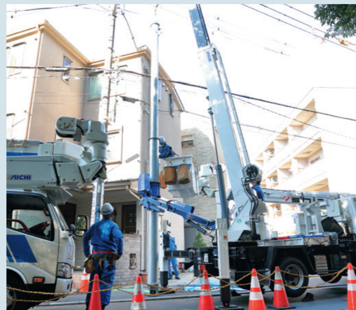
ウインチの吊り上げ操作で伸縮柱を伸ばし、ピンで固定
