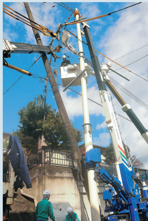
架線物を伸縮柱へ仮移設後に抜柱し、同じ場所へ建柱
