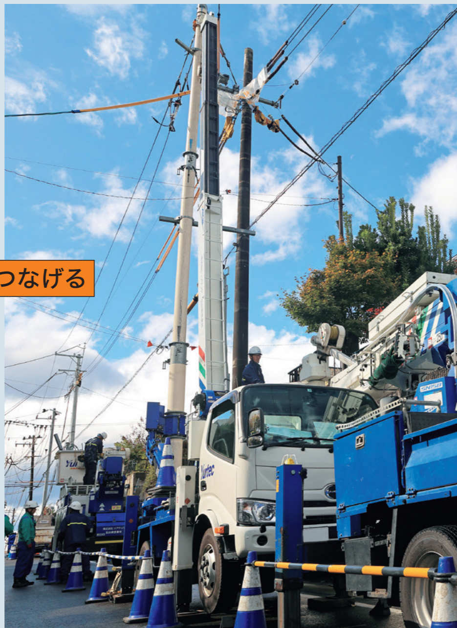
架線物を伸縮柱へ仮移設後に抜柱し、同じ場所へ建柱
