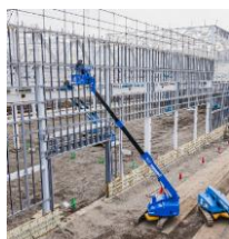
建設現場（無足場工法）
