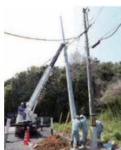
穴掘建柱工事
