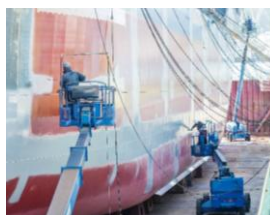
造船現場（無足場工法）
