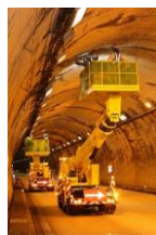
トンネル内点検
