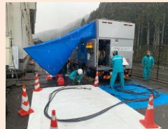
電源車で避難所への電力供給
