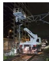
軌道設備の点検
