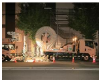
地下送配電ケーブルの更新工事
