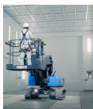
構内施設における各種点検・メンテナンス
