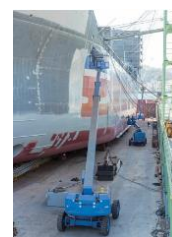
新造船の外板塗装
