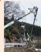
倒壊電柱の改修作業への建柱車、高所作業車の供与
