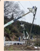
倒壊電柱の改修作業への建柱車、高所作業車の供与
