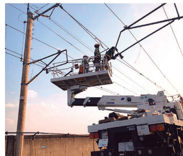
福島県沖地震の復旧工事の様子
