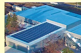
新治工場のソーラーパネル
