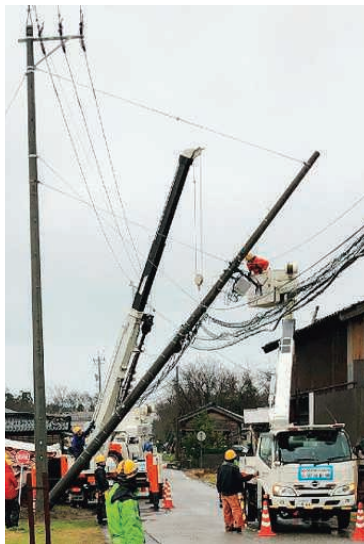
架空線へのかかり木や倒木の除去に対応できる作業車
