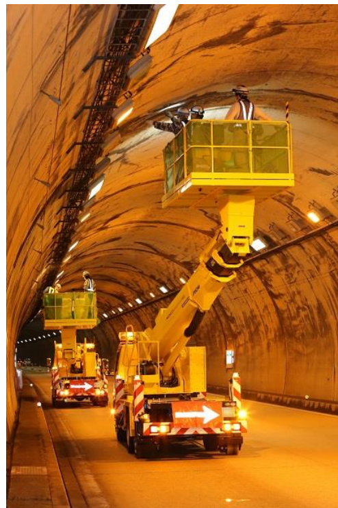
トンネル点検車
