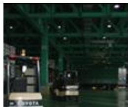
切替前（水銀灯）
