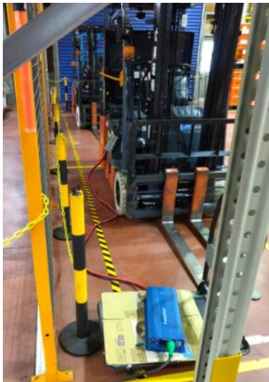
非常用電源(リフト給電)
